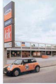
Ausgezeichnet mit dem niedersächsischen Staatspreis für Architektur 2004 - Nahversorgungszentrum Marienwerder / Despang Architekten Hannover Foto: Olaf Baumann
