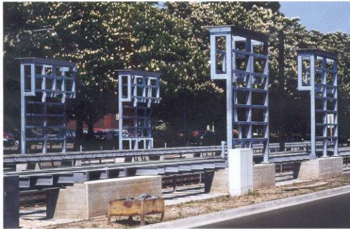
Standaard-modules van thermisch verzinkt staal voor de wachtblokken
