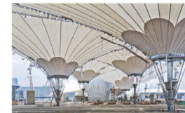
Achse Shanghai Membrandach und Sun Valleys: Knippers Helbig Advanced Engineering, Stuttgart / New York
