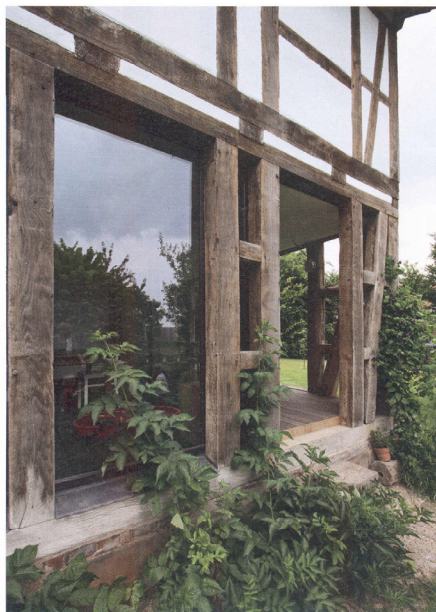
Verbundglaselemente ersetzen die ursprüngliche Ausfachungen. Dadurch wandeln sich geschlossene Wände in transparente Fensterflächen.
