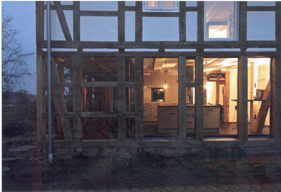
Verbundglaselemente ersetzen die ursprüngliche Ausfachungen. Dadurch wandeln sich geschlossene Wände in transparente Fensterflächen.
